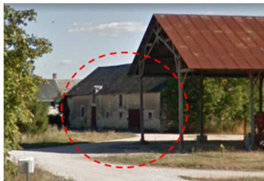
Vue du bâtiment concerné (façade Nord).
