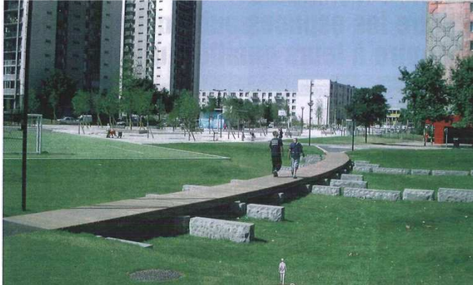
Bassin tampon navsader
