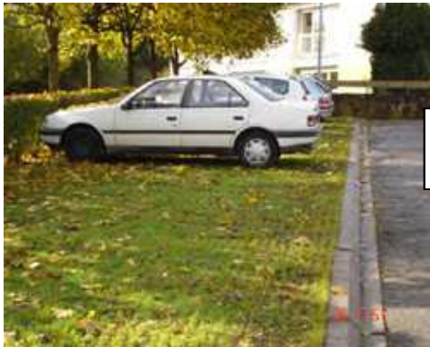
Parking engazonné perméable
