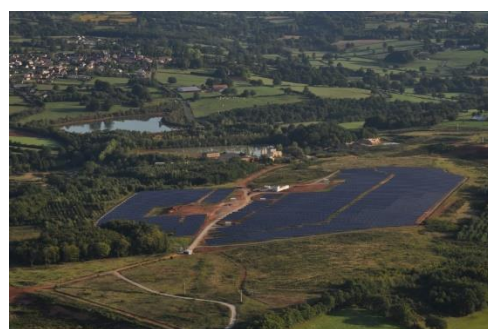
Centrale photovoltaïque de Chaillac
