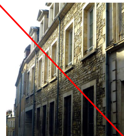
Enduit couvrant laissant apparaître le décor en pierre de taille
