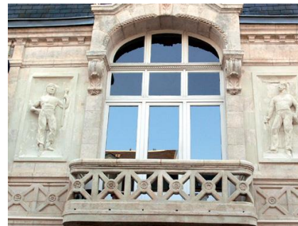
Balustrade en pierre ouvragée
