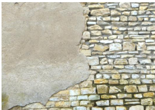
Moellons irréguliers destinés à être enduits
