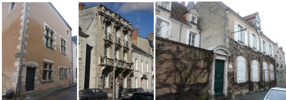
Exemple d'immeubles de la catégorie « patrimoine architectural exceptionnel »
