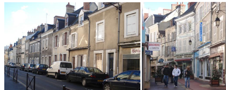
Exemple d'immeubles de la catégorie « patrimoine architectural constitutif de l'ensemble urbain ou d'accompagnement »
