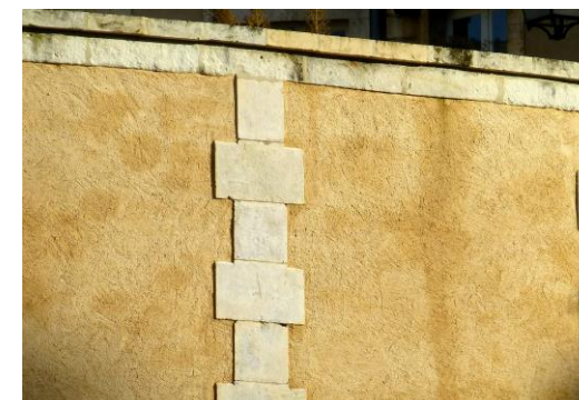
Enduit couvrant laissant apparaître le décor en pierre de taille
