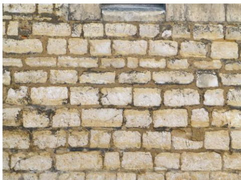
Moellons assisés jointoyés
