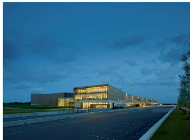
Eclairage limité dans les zones circulées
